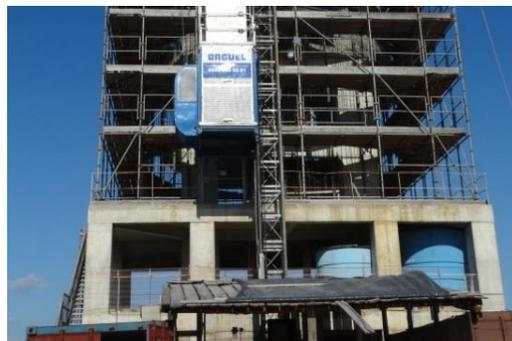
Figuras 72: Caixas d'água instaladas para demandas de abastecimento da obra.
