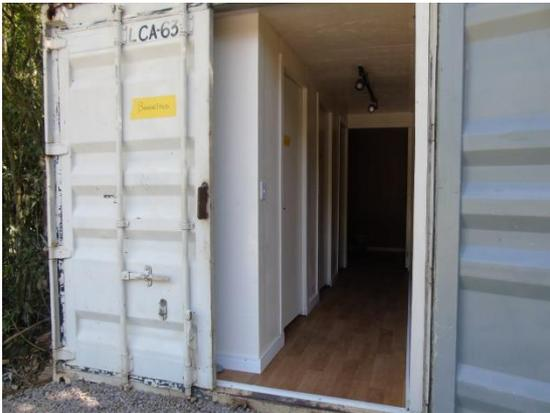
Figuras 73: container instalado como sanitário
