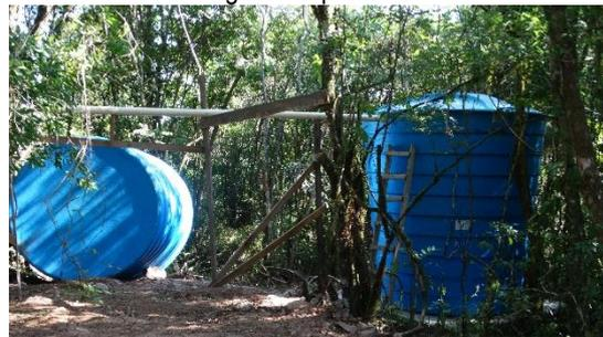
Figura 06: sistema provisório de coleta e armazenamento de efluentes sanitários
