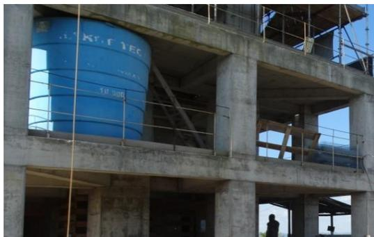
Figuras 71: Caixas d'água instaladas para demandas de abastecimento da obra.
