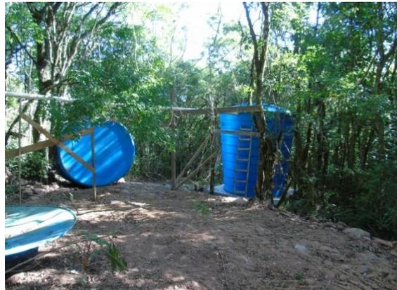
Figuras 74: local de armazenamento dos efluentes sanitários em caixas de fibra para posterior coleta por empresa licenciada
