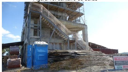
Figura 18: sanitários para funcionários e armazenamento de materiais
